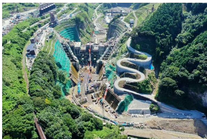
立野ダム建設工事
