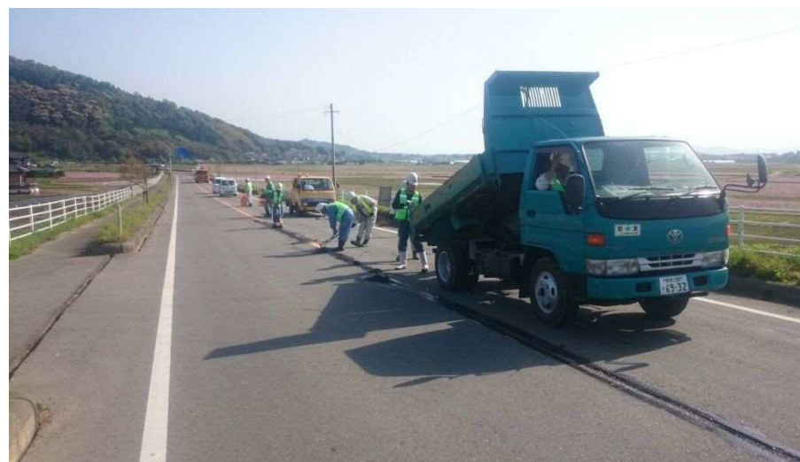
▲ 国道443号補修工事
