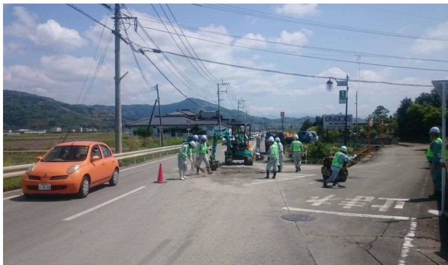
▲ 県道235号益城菊陽線応急復旧
