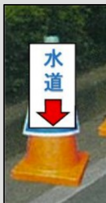
写真1 従前の埋設物の見える化方法
