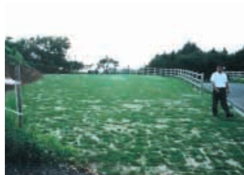
芝生が敷き詰められた観測展望所下段
