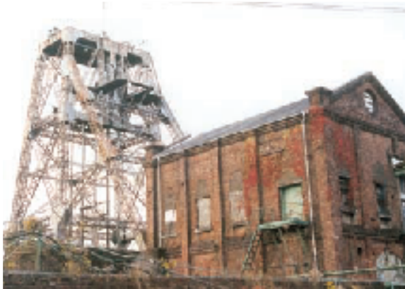
旧万田坑第2 豎坑櫓と巻揚機室
